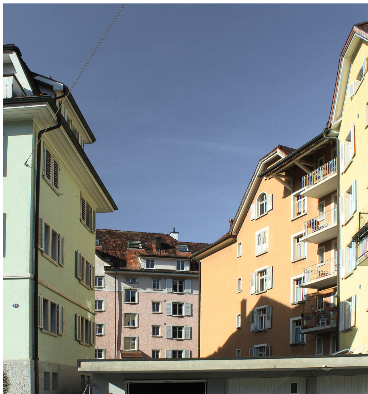
St. Georgen-Strasse 68. St. Gallen (Zone K4)
