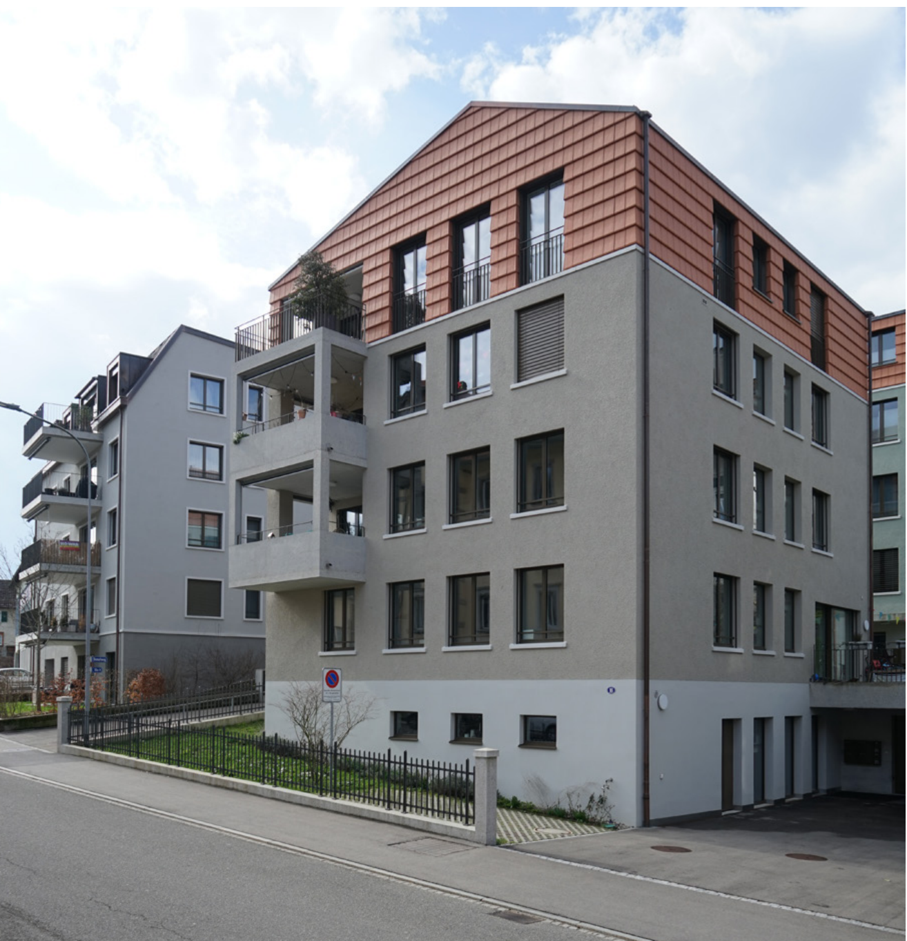
Demutstrasse 16. St. Georgen (Zone W3a)
