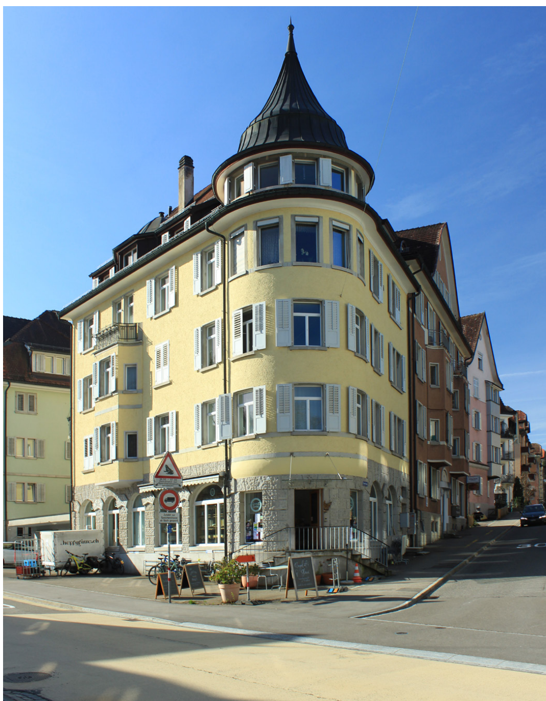
Demutstrasse 1. St. Georgen (Zone K4)
