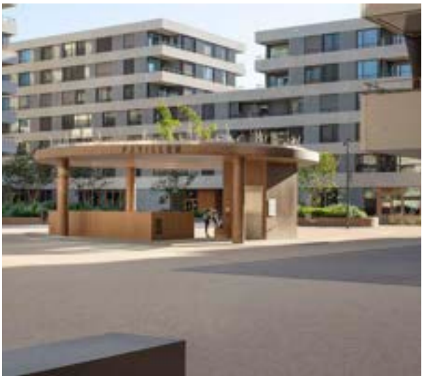
UG Eingang: Quartier « Belle-Terre », Thônex
