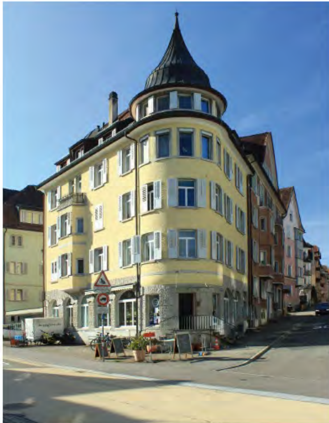
Demutstrasse 1. St. Georgen (Zone K4)
